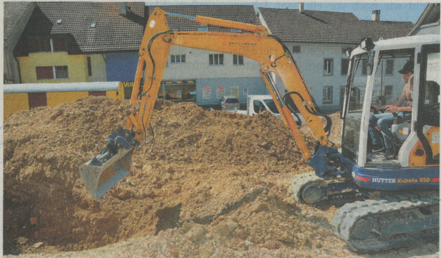
Bereits am ersten Tag gab der Bagger Vollgas.
